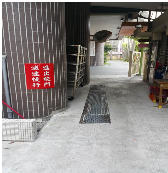
人車分道-機車出入從小門(改善後：增加減速慢行標誌)
